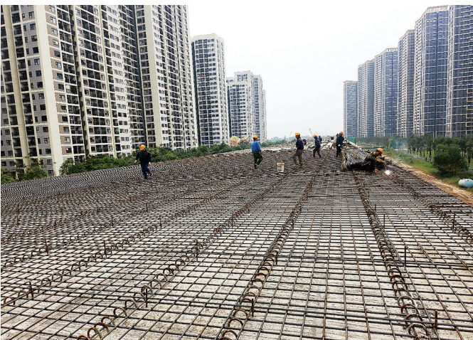
Công nhân thuộc gói thầu XL3 thi công phần bản mặt Cầu Cạn.
