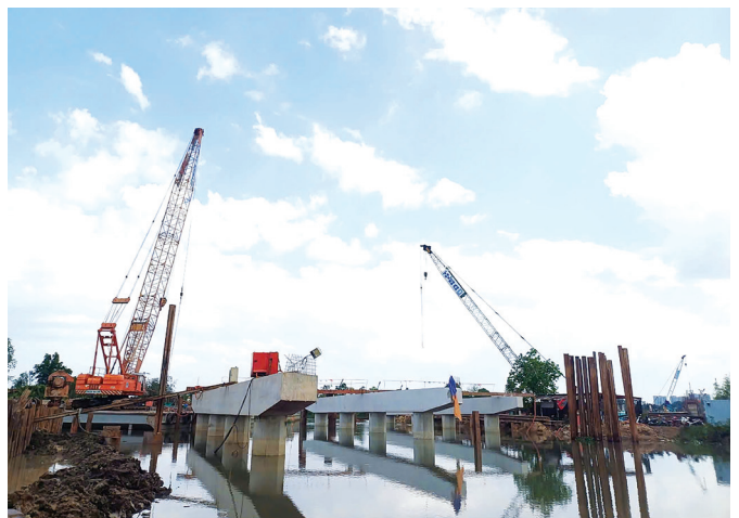
Nhà thầu thuộc gói thầu XL5 thi công phần trụ cầu vượt sông. ▶
