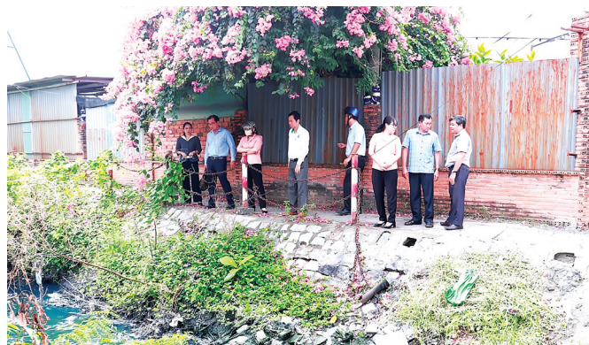
Đoàn khảo sát tại mương thoát nước hẻm 288, đường Dương Đình Hội, phường Tăng Nhơn Phú B. (Ảnh: Lương Hợp)
