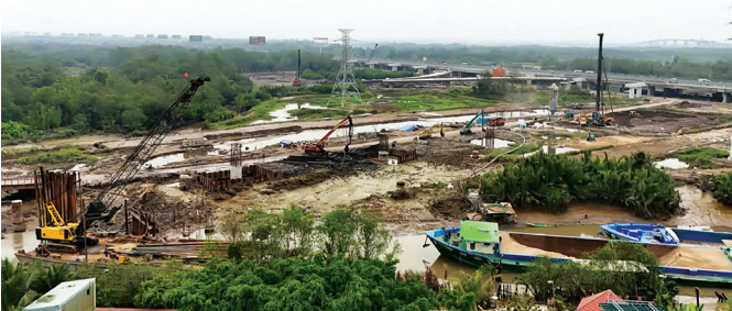
Nhà thầu XL1 tập trung công tác xử lý nền đất yếu phần đường dẫn giao với Cao tốc Long Thành - Dầu Giây.
