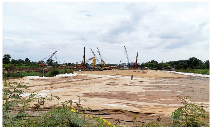
Nhà thầu thuộc gói thầu XL4, bơm cát xử lý nền đường Song Hành.
