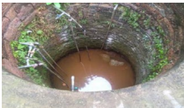
Hình 7. Nước giếng khoan bị nhiễm phen
