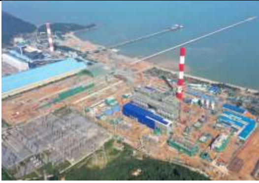
Nhà máy nhiệt điện Vũng Áng (Kỳ Anh)
