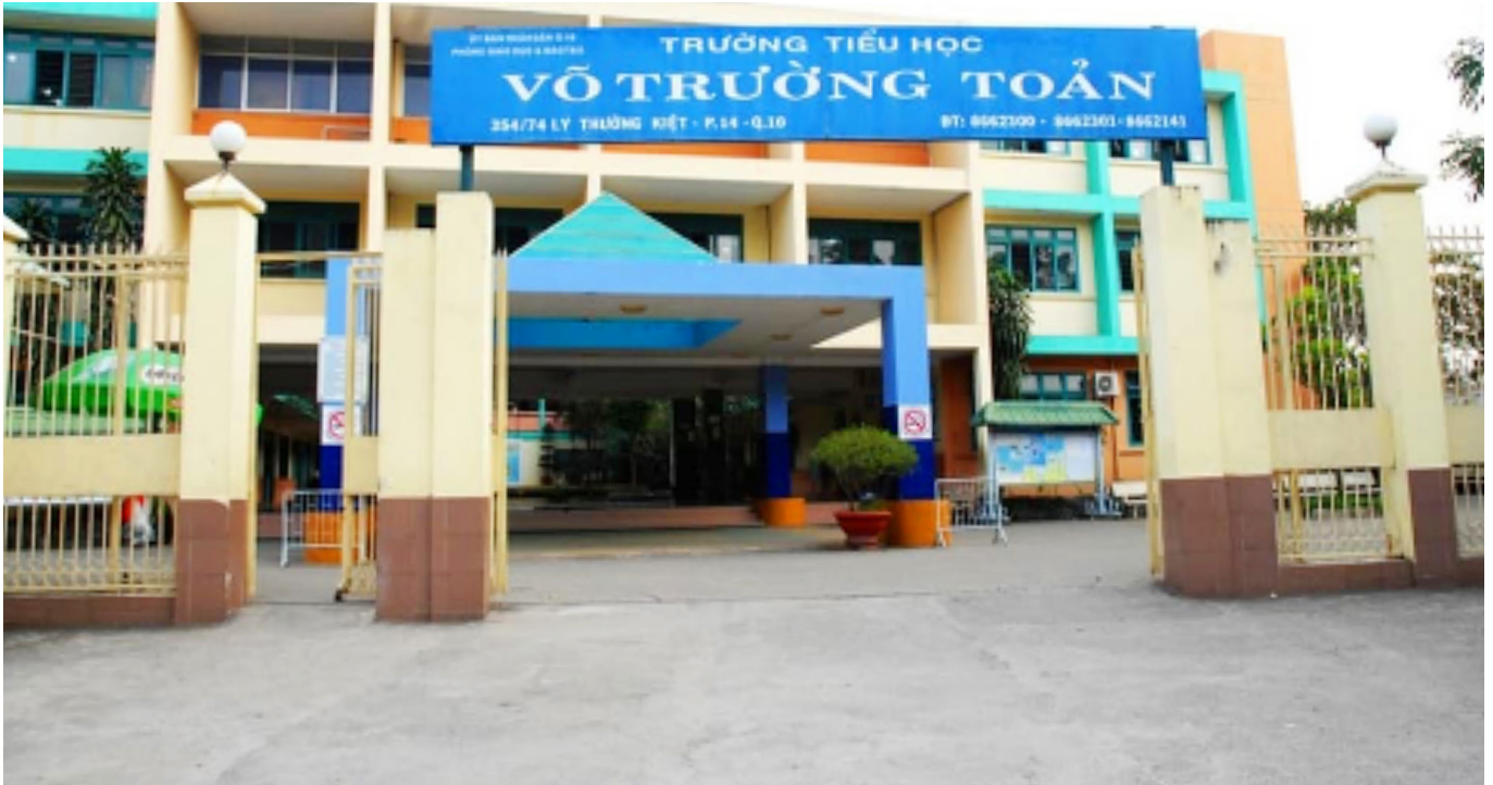
Trường Tiểu học Võ Trường Toản, số 354/74 Lý Thường Kiệt, Phường 14, Quận 10.
