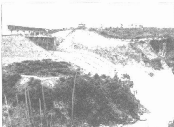
Hình 86. Công trình thủy điện Y-a-ly
