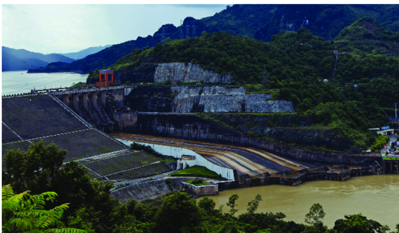
c) Nhà máy thủy điện Hoà Bình
