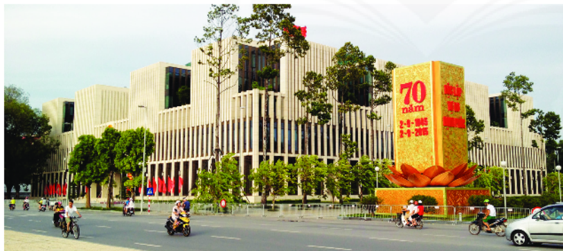
▲ Hình 14.9. Toà nhà Quốc hội sử dụng vật liệu xây dựng xanh
