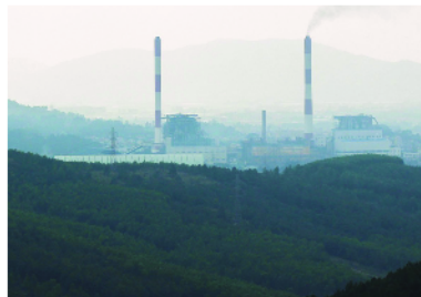
▲ Hình 12.8. Nhà máy nhiệt điện
