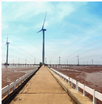
b) Trạm phát điện Bạc Liêu
