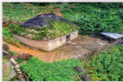
1. Nhà trình tường ở Lào Cai
