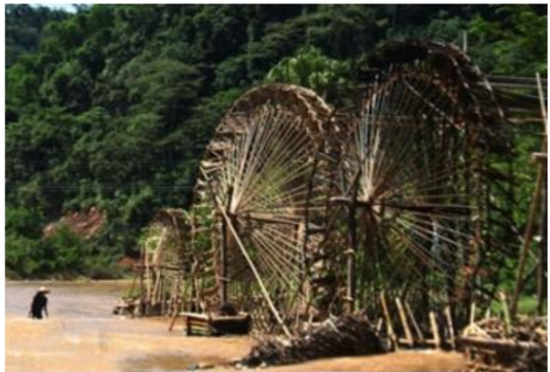
Guồng nước(máy bơm tre) - Công trình thủy lợi độc đáo ở miền núi
