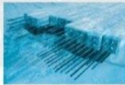
Đúc thành trụ cốt thép
