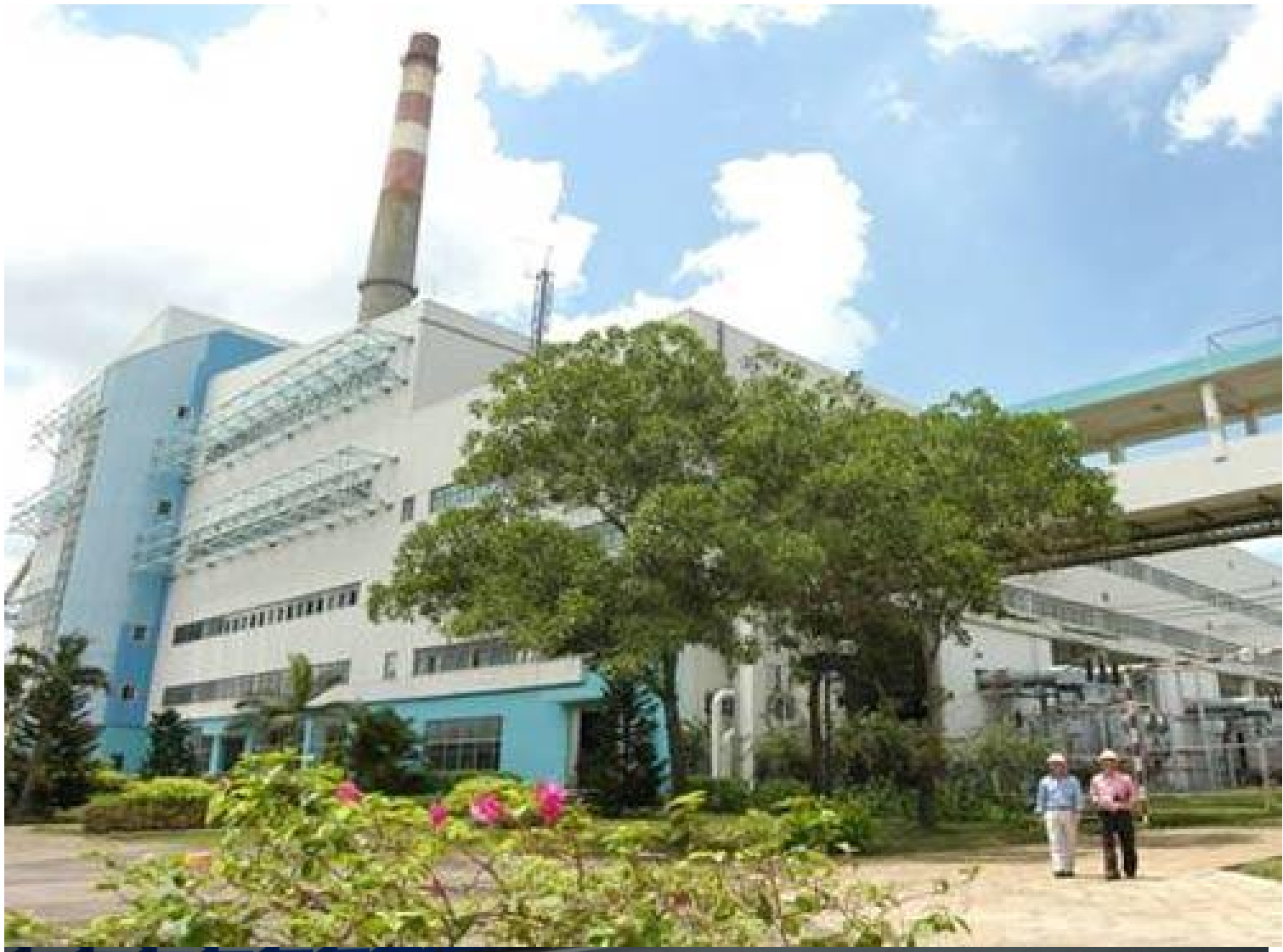
Nhà máy nhiệt điện Hiệp Phước Nhà máy nhiệt điện Uông Bí
