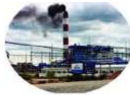
Nhà máy nhiệt điện
