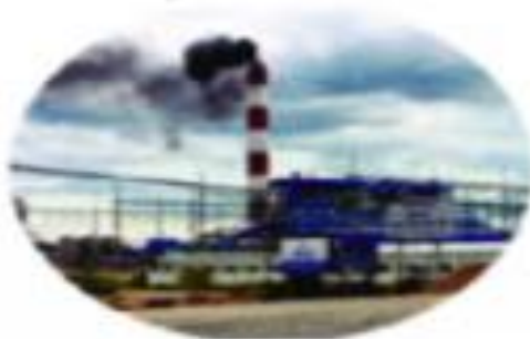
Nhà máy nhiệt điện
