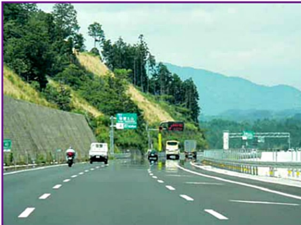
H2.15 ... mặt đường nhìn xa như bị ướt
