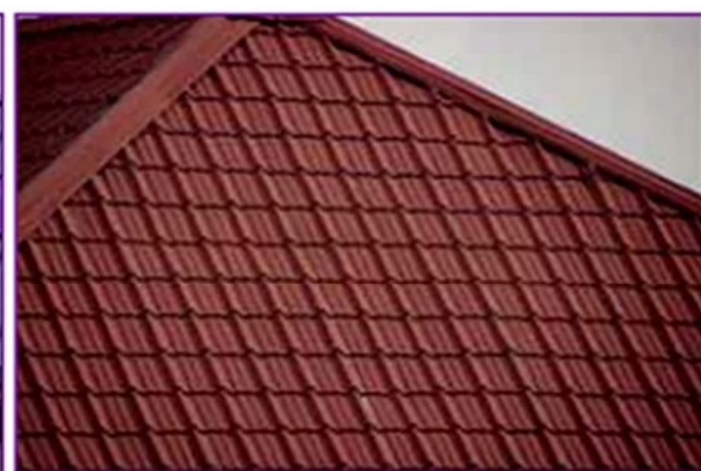
H21.15 Mái nhà bằng tôn mạ giả ngói
