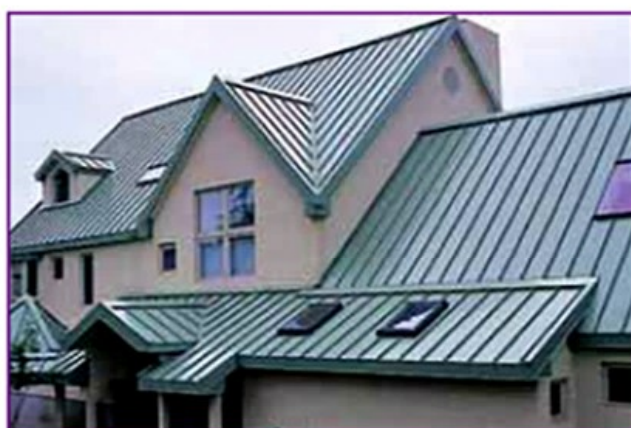
H21.14 Mái nhà bằng tôn mạ kẽm sơn màu
