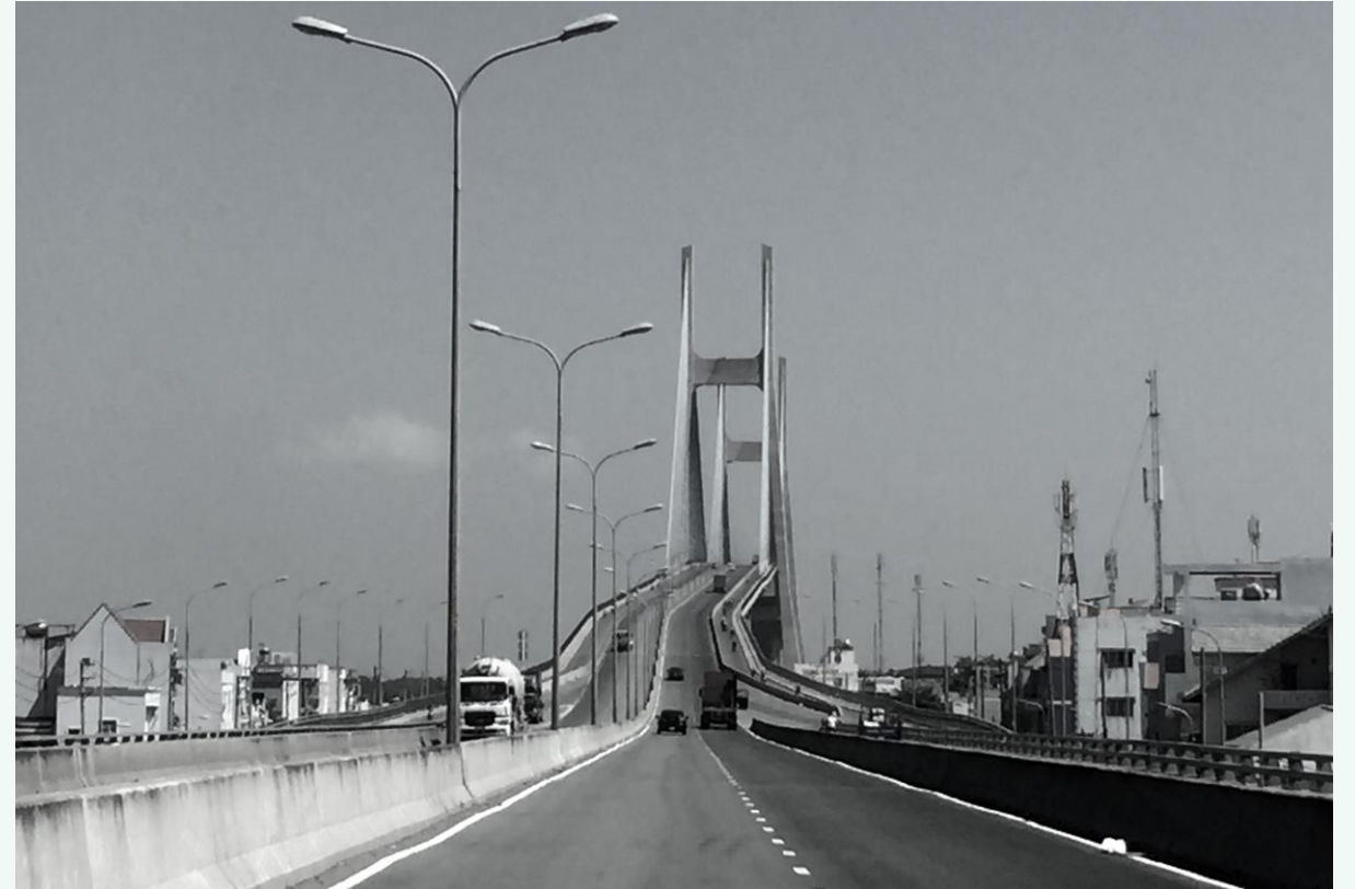
Công trình được thiết kế bởi các tập đoàn tư vấn nước ngoài của Pháp, Australia, Anh và do liên doanh các tập đoàn nhà thầu: Đức, Australia, Pháp và CIENCO 6 xây dựng.
